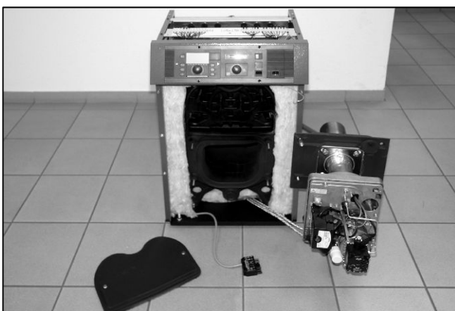
Abb. 127: Bei demontiertem Abgaswärmetauscher die Vorderseite des Kessels öffnen und die Brennertür in die Wartungsposition bringen. Jetzt kann der Kessel mit einer Bürste gereinigt und ausgesaugt werden.
