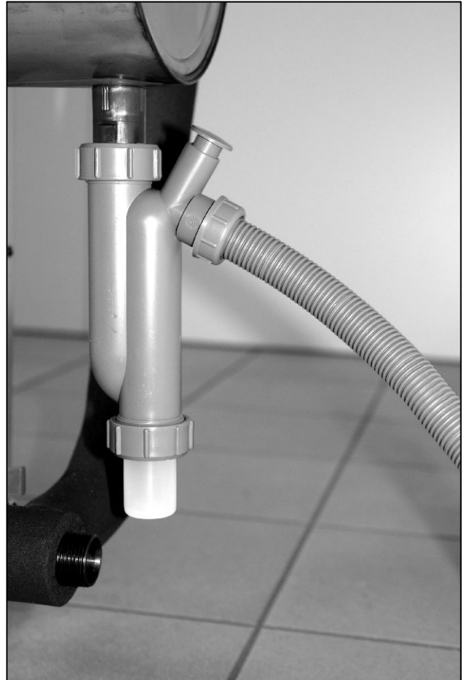
Abb. 124: Siphon und Kondensatleitung demontieren und spülen.
