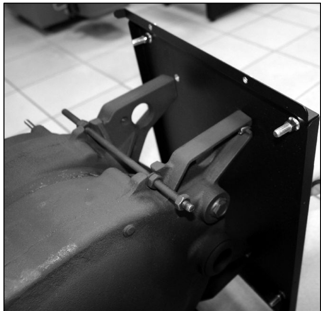
Abb. 14: Den Kesselblock mit der Unterseite an die Palettenkante ziehen und die Schrauben an der Rückseite einhaken.
