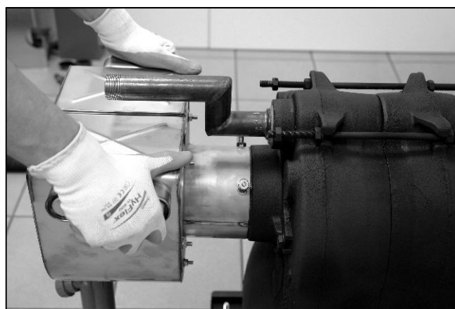
Abb. 31: Abgaswärmetauscher fest auf den Abgasstutzen des Kessels schieben.
