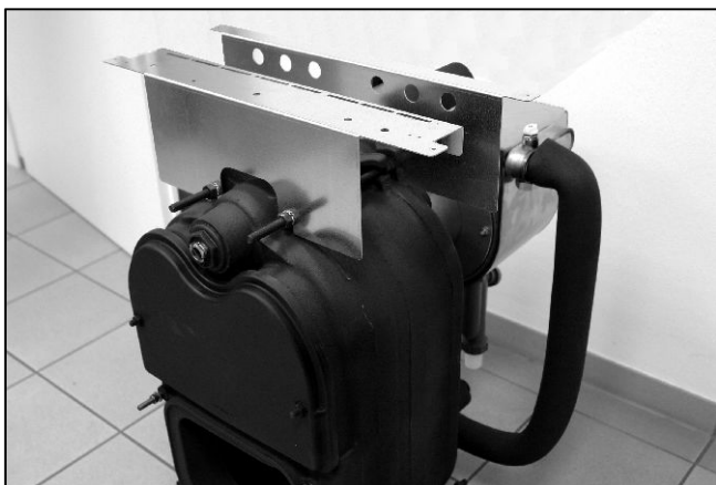
Abb. 49: Die äußeren Muttern der oberen Kesselzugstangen lösen und die Verkleidungstraversen von oben bis zum Anschlag auf dem Kesselblock, waagrecht aufschieben und mit den Muttern festklemmen. Für das vordere Blech Zahnscheiben \varnothing 10,5 mm verwenden.
