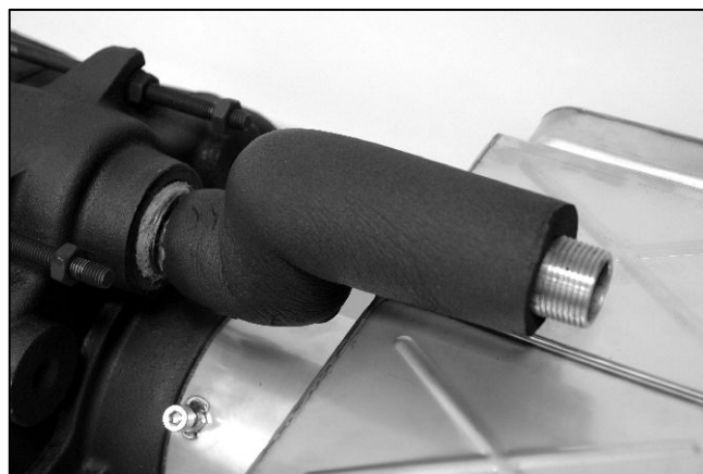
Abb. 42: Mit einem kurzen Stück Isolierschlauch das Vorlaufrohr isolieren.
