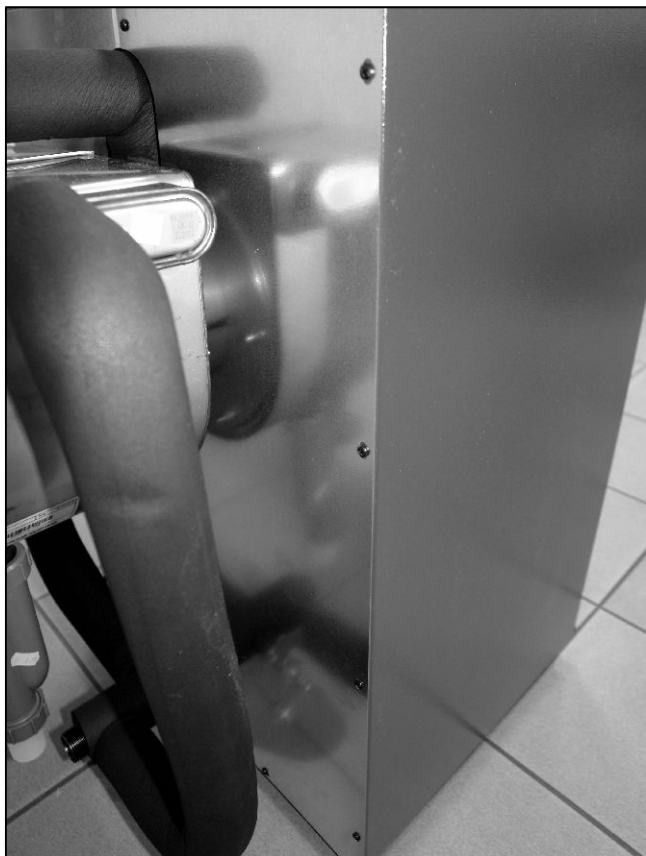
Abb. 63: Dann die rechte Seite befestigen.
