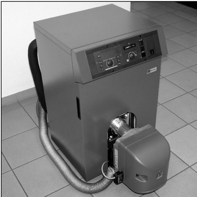
Abb. 99: Fertig montierter Kessel mit Zuluftschlauch..
