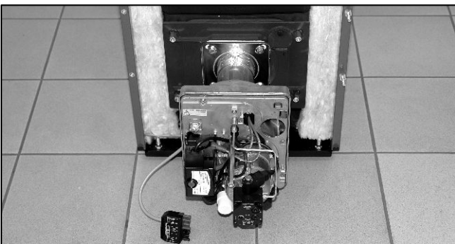
Abb. 89: Brenner wieder montieren.
