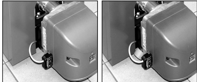
Abb. 83: Brenner ohne und mit Luftstützen
