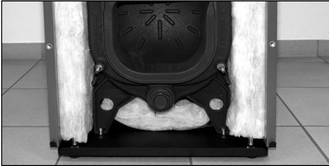
Abb. 56: Bodendämmung einlegen.
