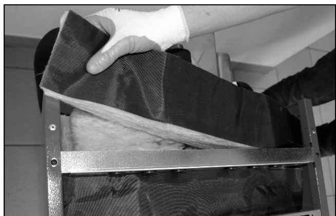
Abb. 61: Obere schmale Isolierung auf die Rückwandisolierung auflegen.
