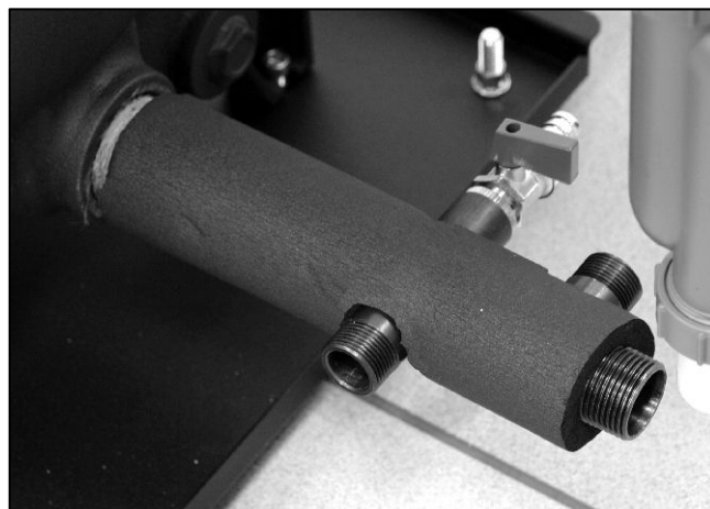
Abb. 43: Mit einem kurzen Stück Isolierschlauch das Rücklaufrohr isolieren.
