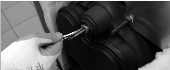
Abb. 68: Kapillarrohrfühler bis zum Anschlag tief in die Tauchhülse einführen.
