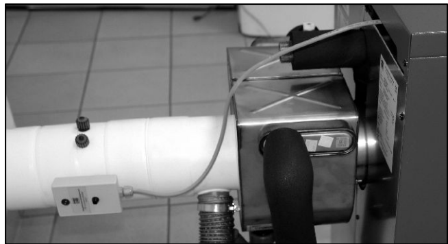
Abb. 97: Abgaswärmetauscher mit Anschluss DN80/125 und Kesselanschluss mit Abgastemperaturbegrenzer DN80/125.
