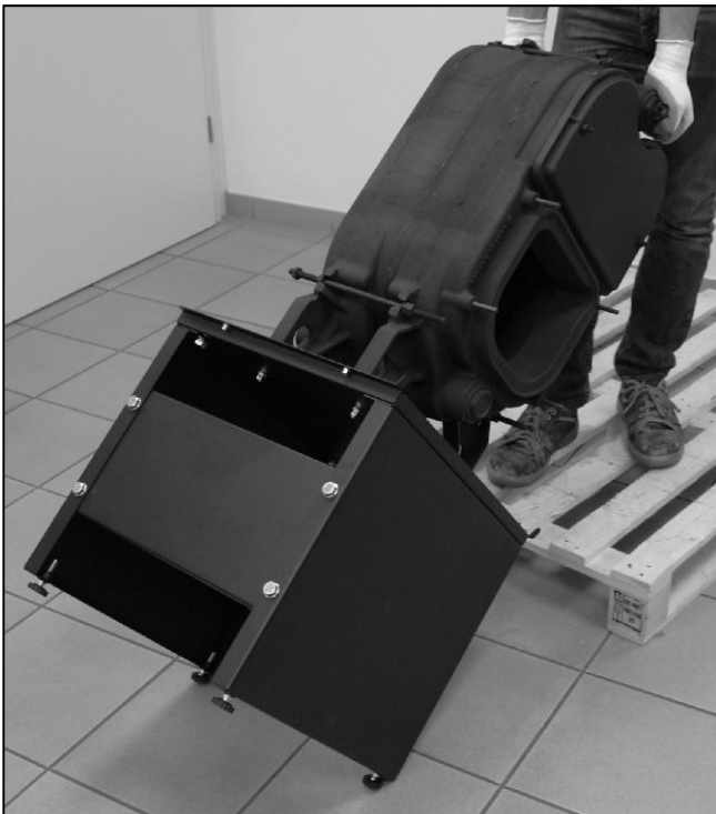
Abb. 21: Aufrichten des Kessels mit Kesselsockel.
