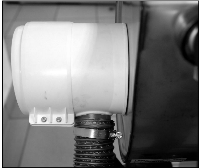
Abb. 96: Anschluss DN80/125 aufstecken und den Zuluftschlauch mit der Bandschelle befestigen.
