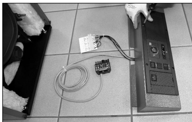
Abb. 65: Vorbereitung: THETA-Kesselgrundschaltfeld in dem Schaltfeldträger mit Blechschrauben befestigen. Ausrichtung beachten!
