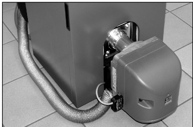
Abb. 98: Zuluftschlauch am Brenner anschließen.
