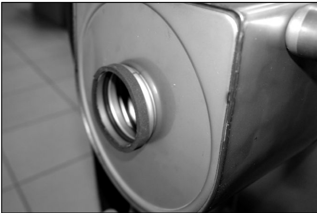
Abb. 95: Moosgummidichtung um die Muffe des Wärmetauschers kleben.
