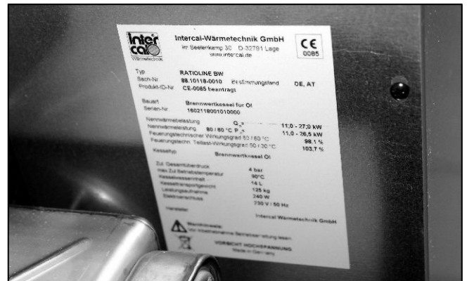
Abb. 92: Kesseltypenschild auf Rückwand aufkleben
