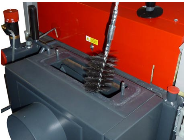
Vorführung der Reinigung des Rauchkanals mit Drahtbürste.
